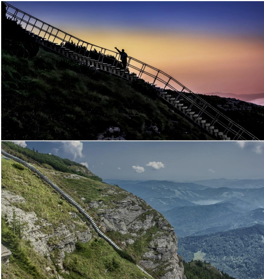
Figura nr. 19a La sfârșitul lunii iulie s-au terminat lucrările de amenajare și a fost dată în folosință scara de acces către vf. Toaca, realizată printr-un proiect al Consiliului Județean Neamț "Eliminarea și securizarea zonelor periculoase din Masivul Ceahlău - scări Varful Toaca".
