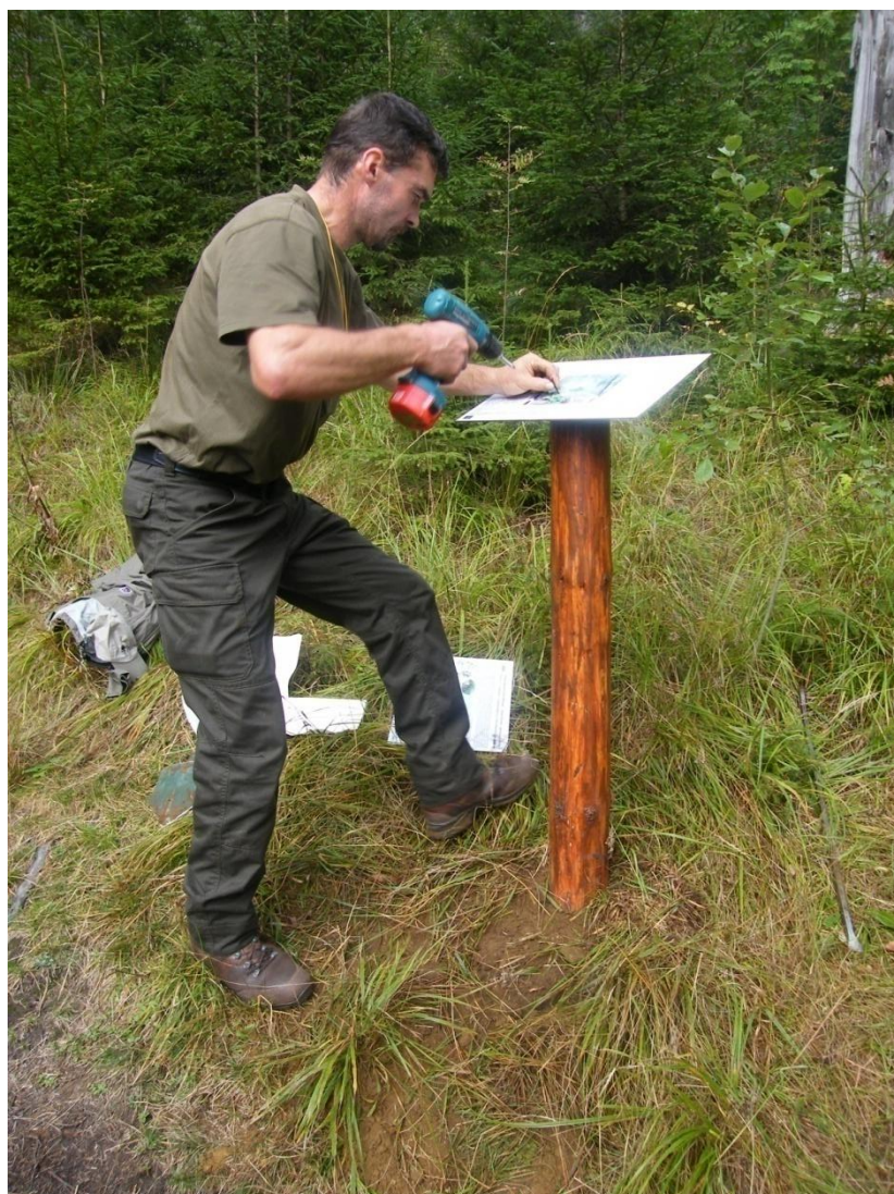
Fig. 13. Înlocuire panouri deteriorate pe traseul tematic.
